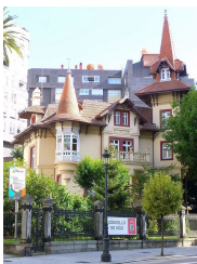
• Edificio el Pilar.
