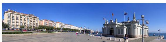
Paseo de Pereda con el Palacete del Embarcadero en primer término.
