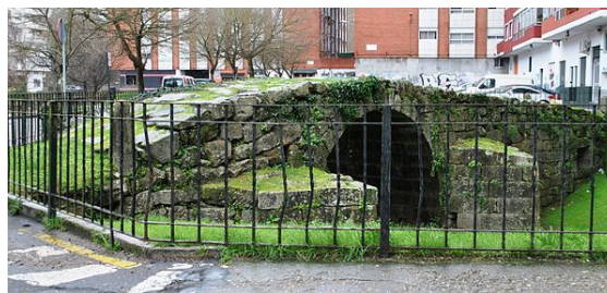
Puente romano en Castrelos.
