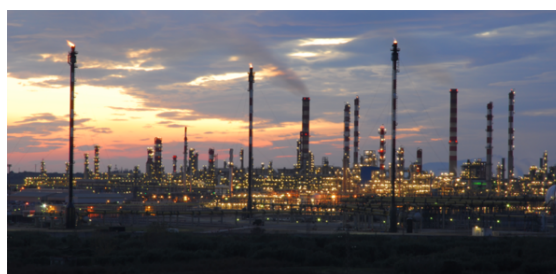
Refinería de petróleo en Poble de Mafumet (Tarragona).
