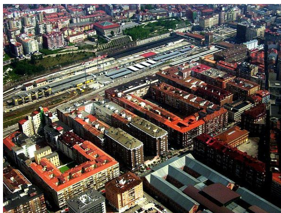
Vista aérea de las estaciones de ferrocarriles de Santander.
