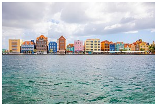
Edificios en la parte histórica de Willemstad , la Capital de la Isla
