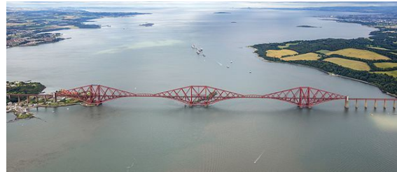
El puente de Forth, que conecta Edimburgo con el noreste de Escocia.
