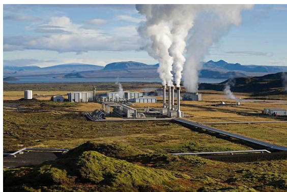
La Central Geotérmica de Nesjavellir. Prácticamente, toda la electricidad de Islandia proviene de fuentes de energía renovable. [99]
