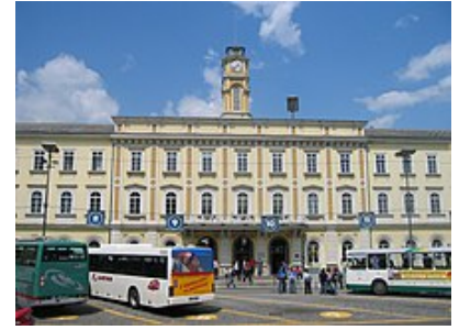
El edificio principal de la estación de Liubliana
