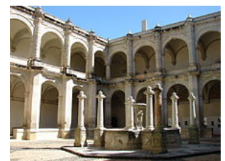
Patio interior del ex-convento.
