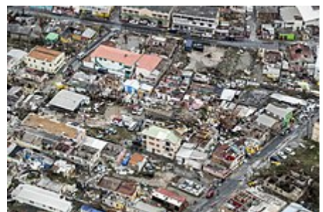
Vista parcial de los daños que causó el Huracán Irma en San Martín en 2017
