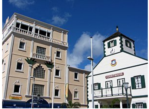
Edificio del Parlamento de San Martín al lado de la Corte Constitucional
